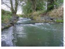
Sohlschwelle und massiver Uferverbau verhindern dynamische Eigenentwicklung (Fkm 0+900)
